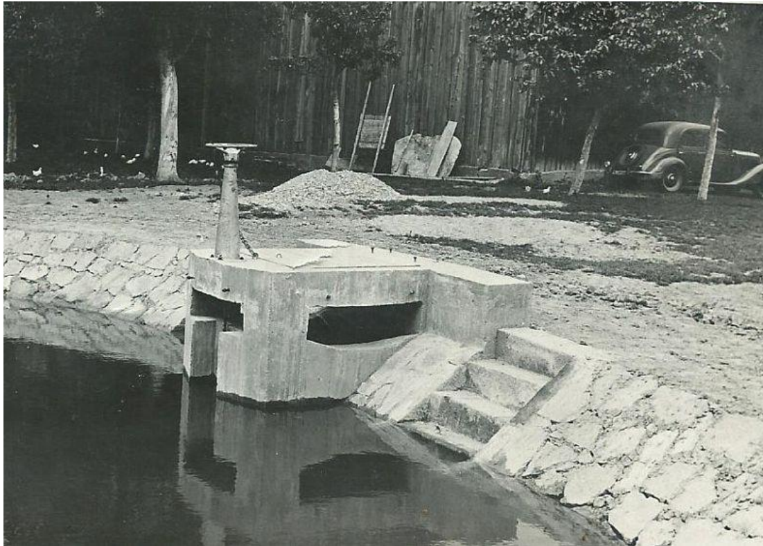
Weiher nach dem Ausbaggern und neuer Randbefestigung 1950
