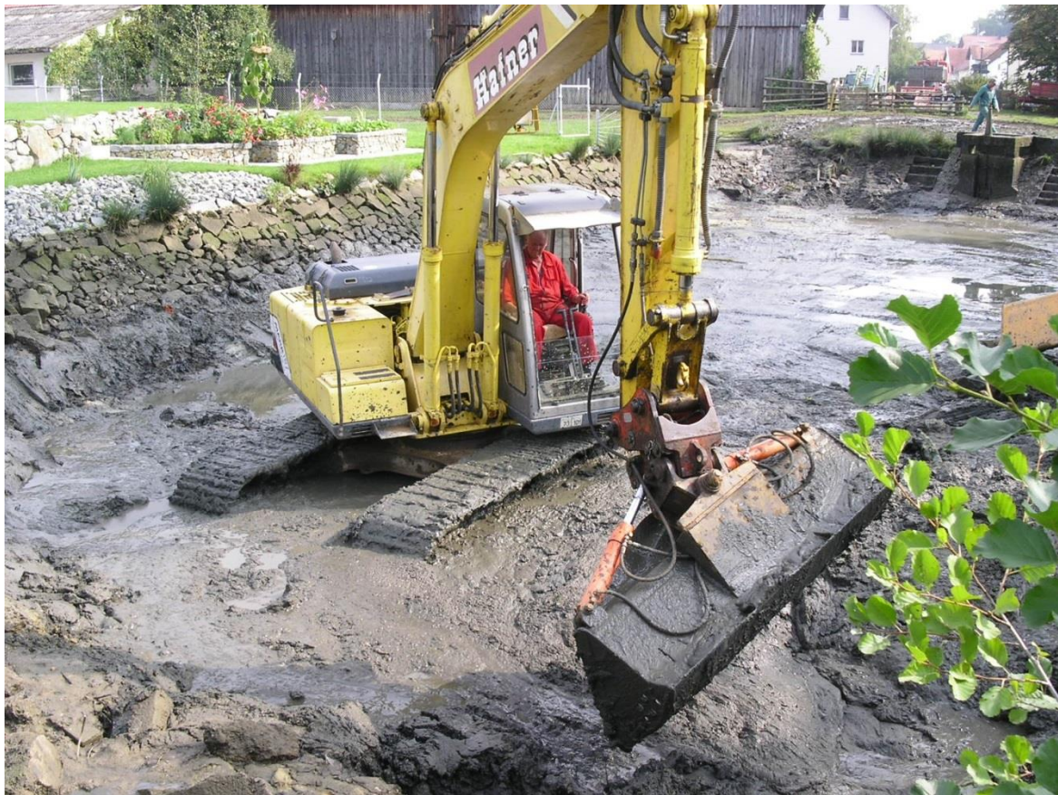
Letztes Ausbaggern des Weihers 2009. Hier sieht man noch die Granitsteine die mühsam an die Böschung geschichtet wurden.
